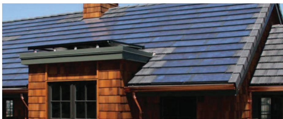
BIPV på tak. Foto: Applied Solar.
